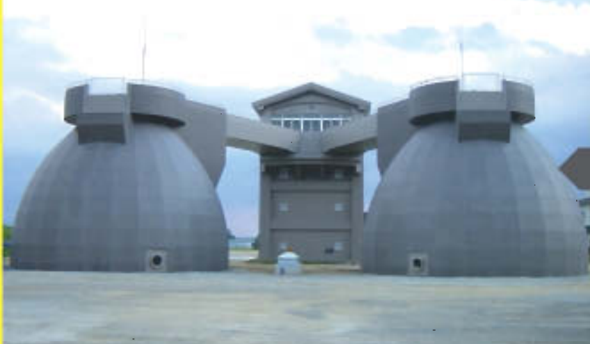
② 京都木津川浄化センター
