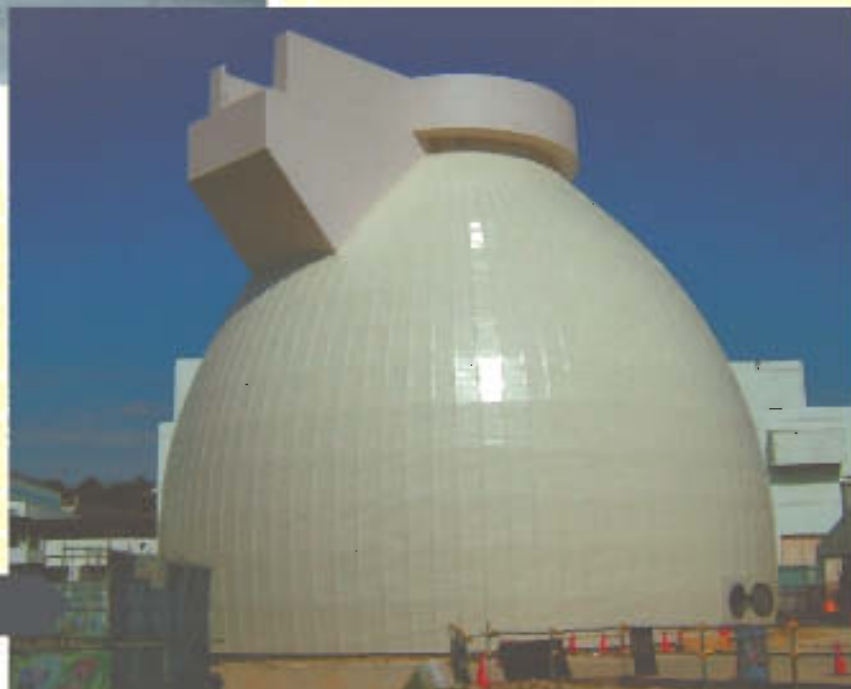
③ 神戸垂水卵形消化槽
