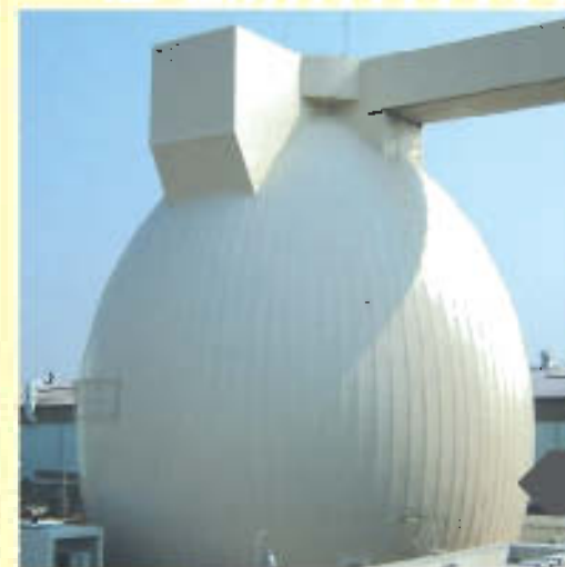
⑥ 神戸東灘消化タンク3号機
