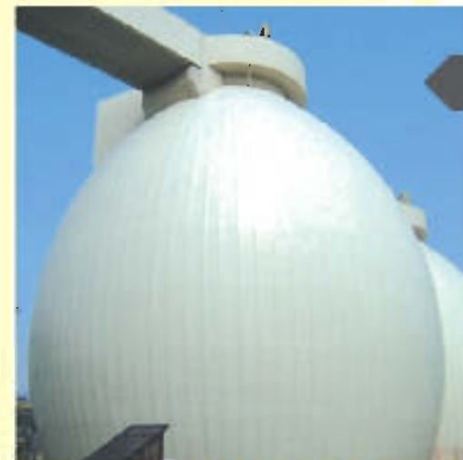
④ 神戸東灘消化タンク1号機
